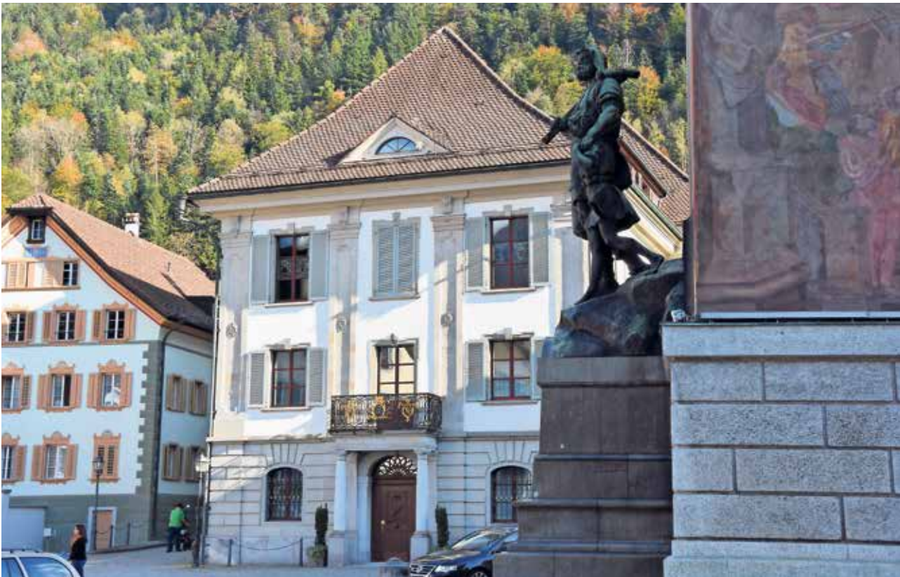
Im Rathaus wird das Dachgeschoss umgebaut, die WC-Anlage erweitert und der Lift ersetzt. FOTO: ARCHIV UW
